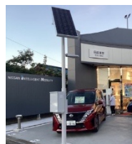
非常用蓄電池付き 太陽光パネル街灯
